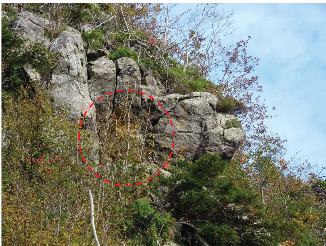
Bilde 4. Parti der steinsprang nylig har løsnet fra (rød, stiplet sirkel). Bildet er tatt mot nordøst.
