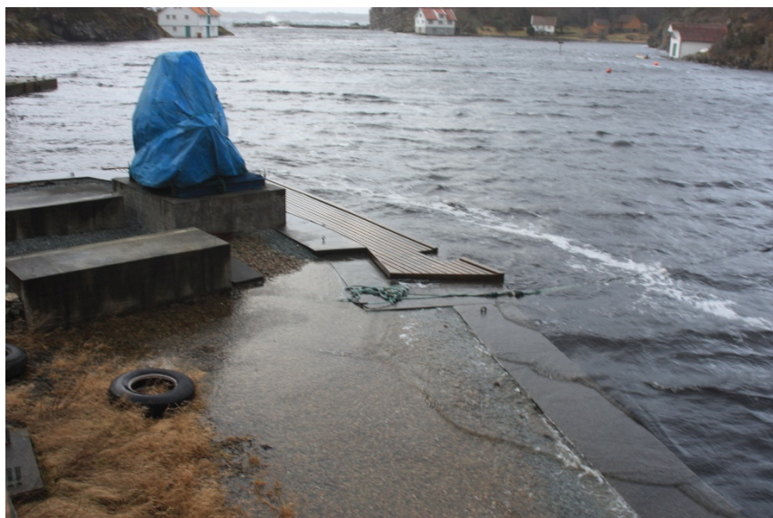
Bildet viser kai på 136/6 i springflo-situasjon.
